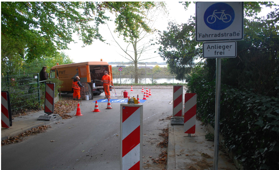
(Foto: Markierungsarbeiten in der Fahrradstraße)
