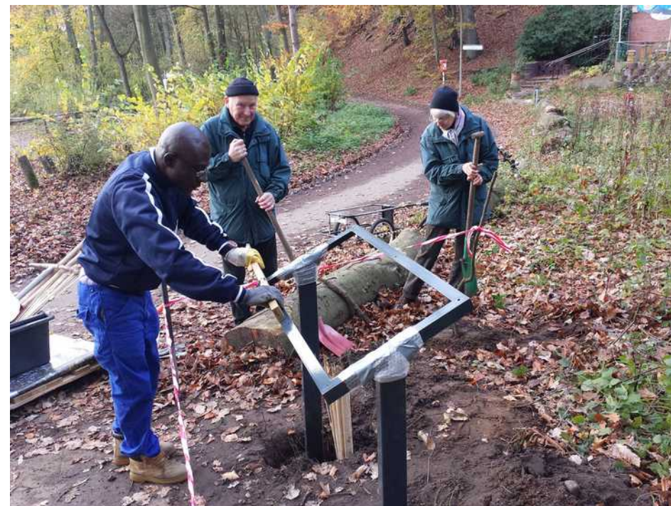
Abbildung 14: Installation der Tafelträger am Rissener Ufer beim Wittenbergener Teich
